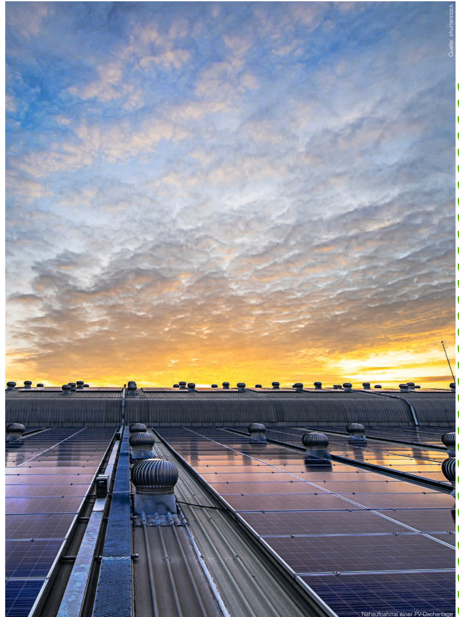
Nahaufnahme einer PV-Dachanlage
