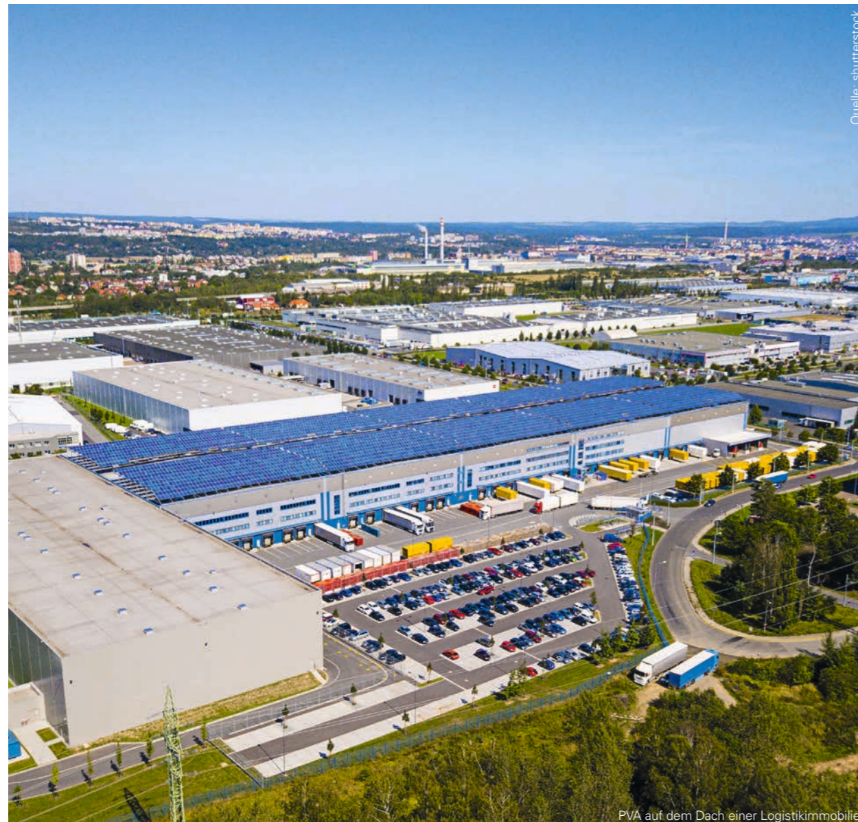
PVA auf dem Dach einer Logistikimmobilie
